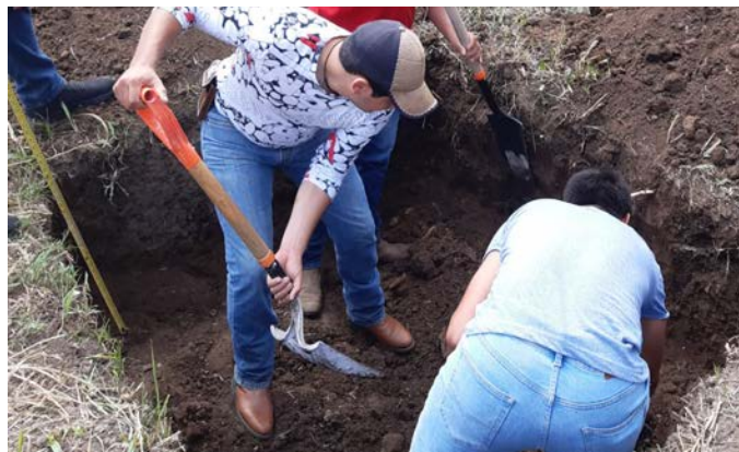
Figura 2. Medición de profundidad y excavación de la fosa
