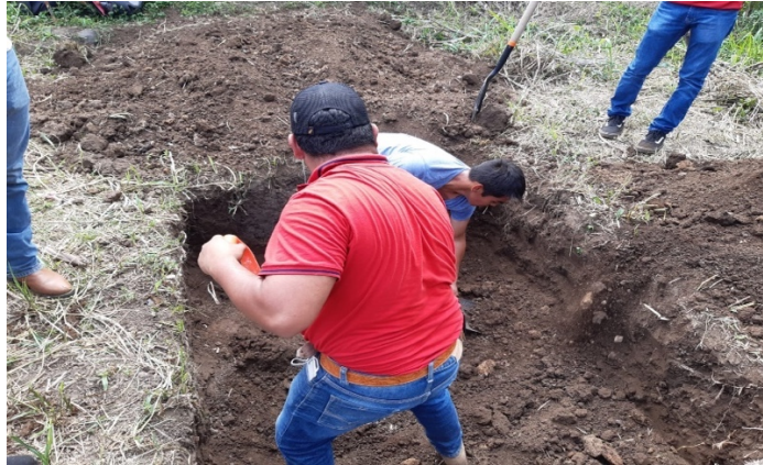
Figura 1. Excavación de la fosa
