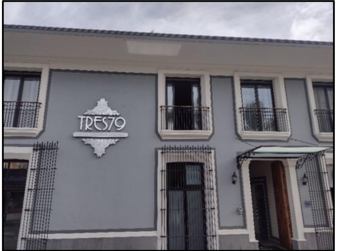
Figura 1. Fachada del Hotel Boutique Orizaba en Colón Pte. No. 379 Fuente: Archivo (2022)
