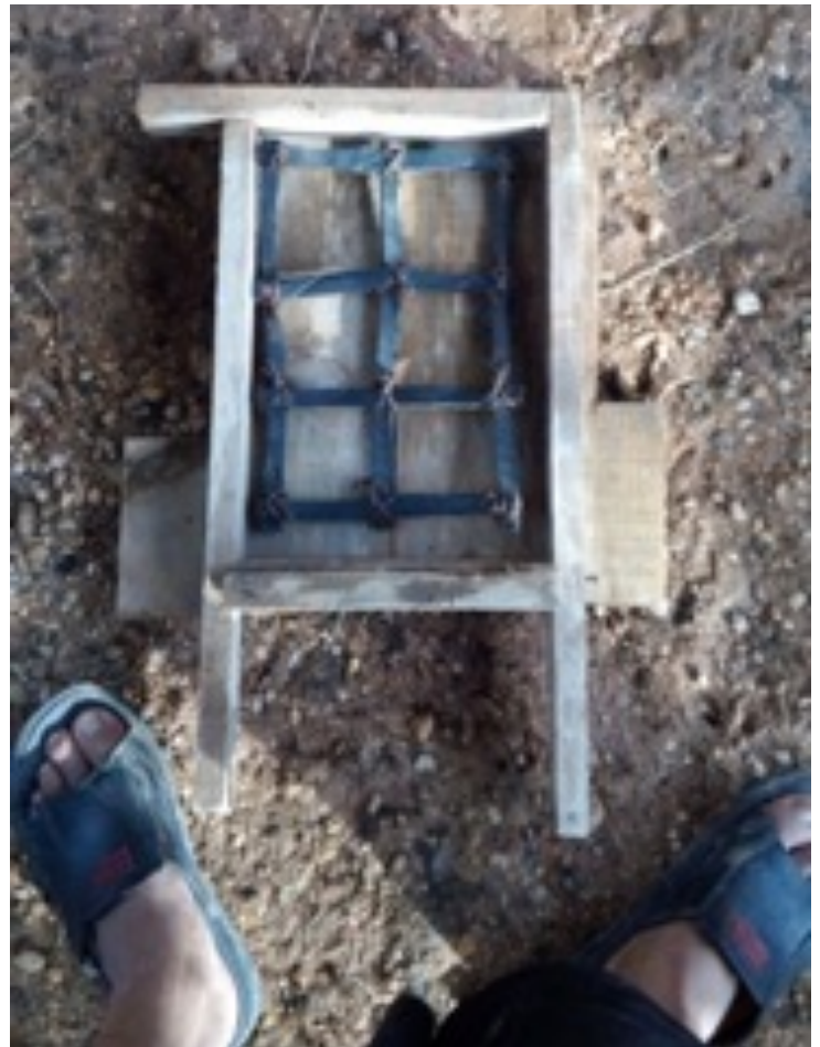
Malla con el molde de la cimbra
