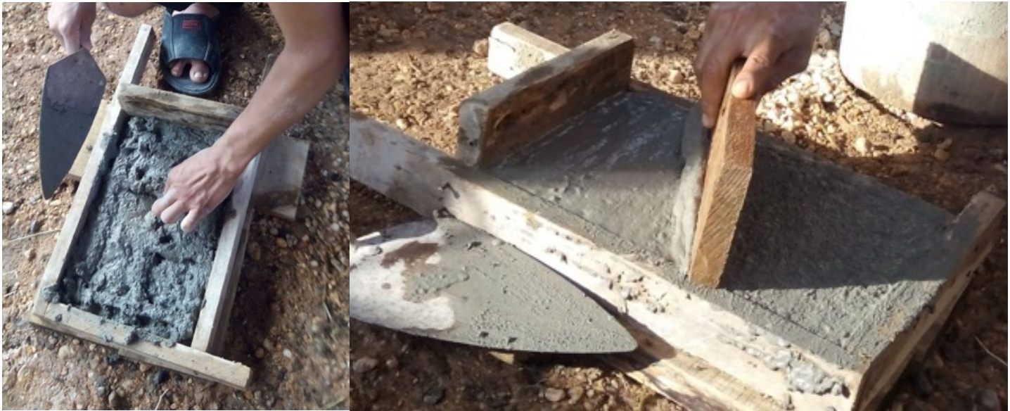
Figura 2.4 colocado de mezclas
