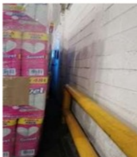
Figura 18: cercos sanitarios existentes.
