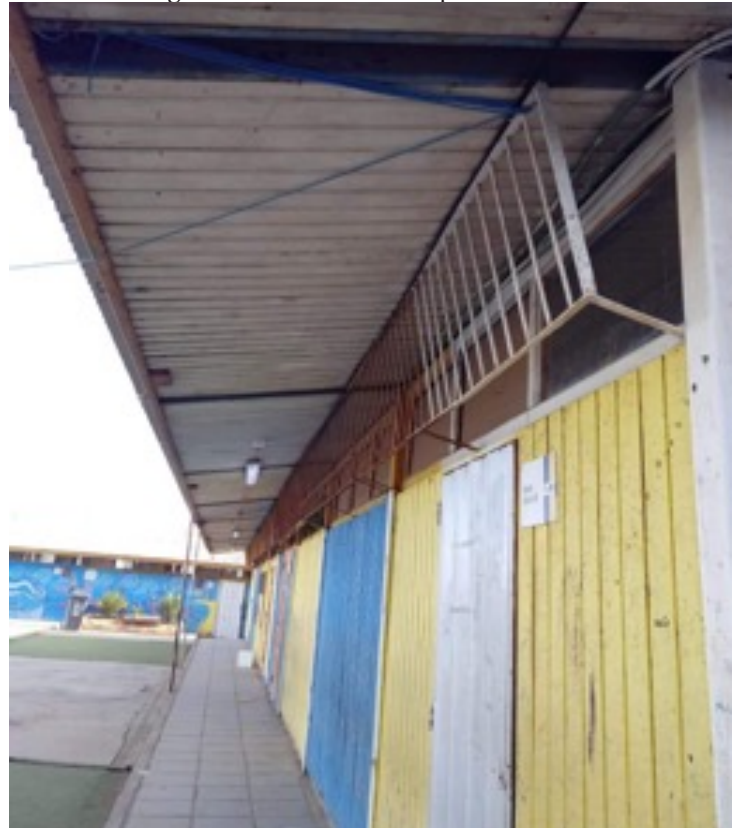
Figura N°6: Entrada Principal Norte ETP.
