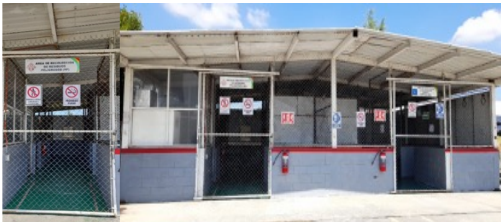
Imagen 1. Almacén de Residuos peligrosos fuera de la planta.
